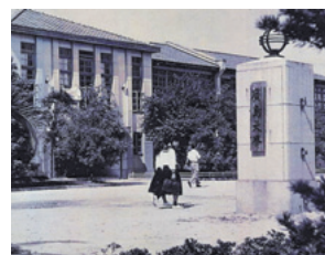
広島大学附属図書館 (旧広島文理科大学附属図書館) (昭和30年頃)
